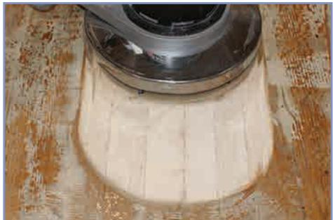
La herramienta de preparación para duelas de **Diamabrush®** by **Malish®** es el primer paso para el proceso adecuado del acabado de pisos de madera.
